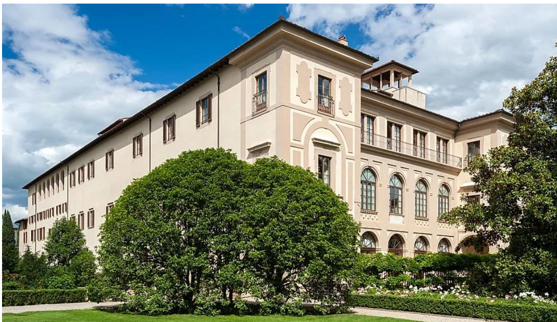
Рис. Е.1. Зовнішній вигляд готелю
