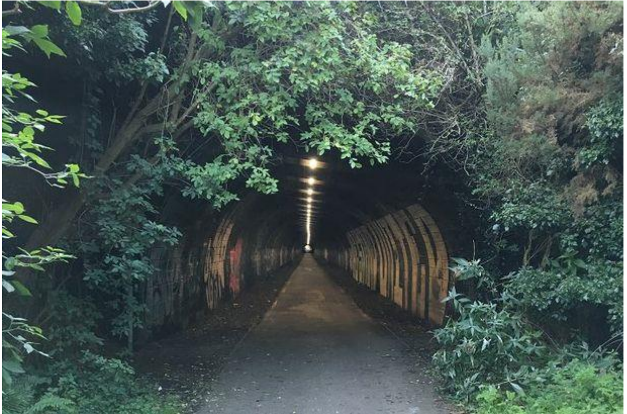
Рис. Е.1. Вхід у тунель закинutoї залізничної лінії
